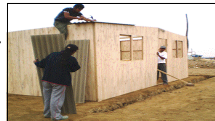
Tipo de casa pre-construida que será ofrecida a familias afectadas en Chincha y Pisco
